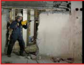
Een breekhamer brengt een groot risico met zich mee omwille van de trillingen en het gewicht van de motor.
