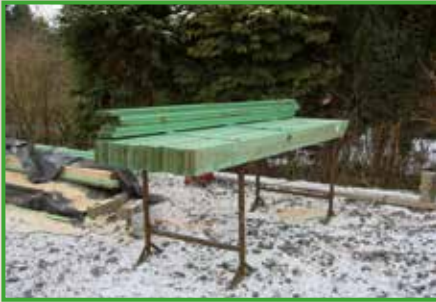
Stutbalken stockeren op de goede hoogte.
