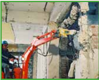
Een breekhamer brengt een groot risico met zich mee omwille van de trillingen en het gewicht van de motor.
